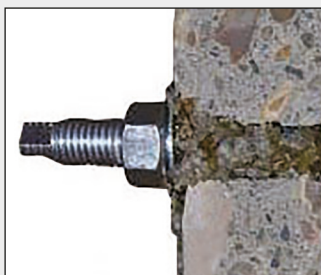
Varetas de âncora em betão sólido
