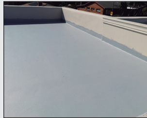
Paredes de parapeitos e cintilantes
