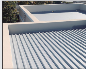
IBR & Telhados de betão
